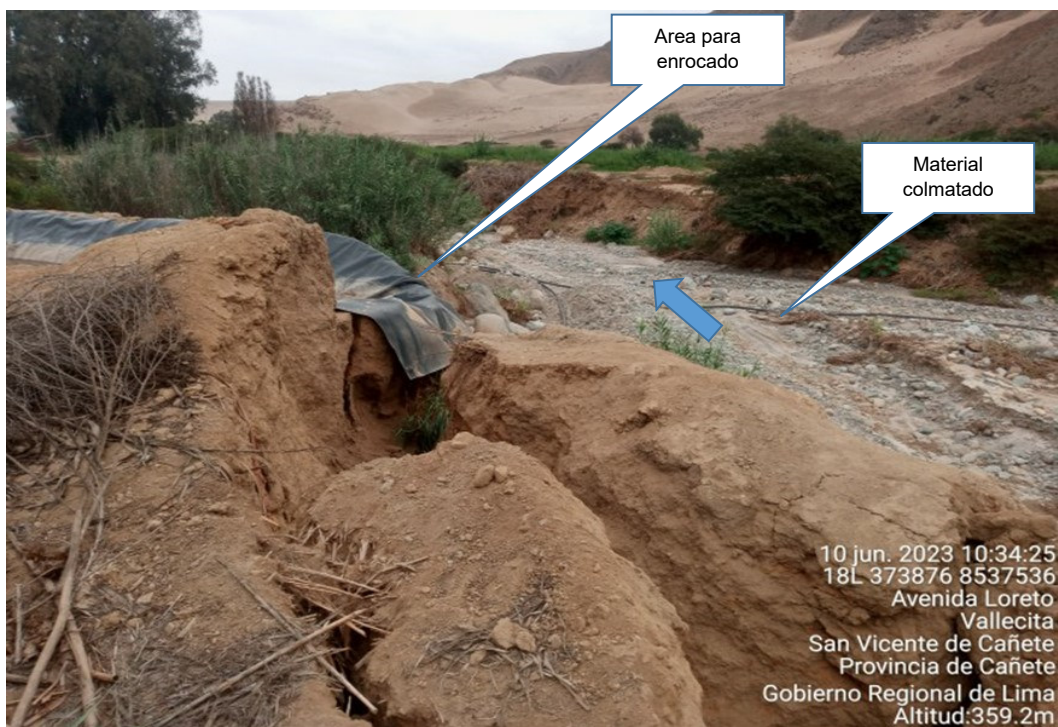
FIGURA N°02: : TRAMO CRÍTICO, A 50m DEL PUNTO DE INICIO AGUAS ABAJO CON VISTA AGUAS ABAJO, MATERIAL COLMATADO Y DAÑO DE TALUD MARGEN IZQUIERDO.
